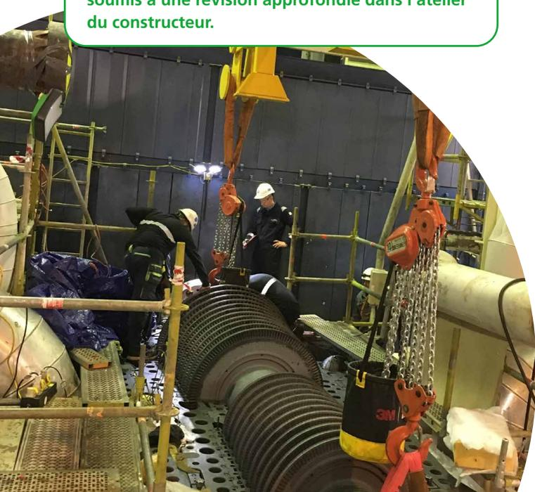
Après l'inspection du compresseur de la turbine à gaz, les paliers et quelques ensembles d'aubes de stator ont été remplacés. Les pièces utilisées pour la combustion et la turbine ont été renouvelées.
