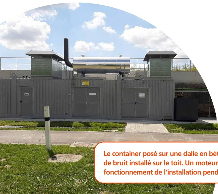
**Le container posé sur une dalle en béton avec ses deux tours de ventilation et le système de réduction de bruit installé sur le toit. Un moteur diesel capable de démarrer en dix secondes rend possible le fonctionnement de l'installation pendant 25 heures durant une coupure électrique du réseau.**
