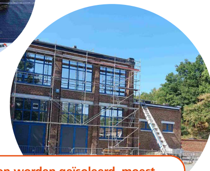
Voordat het dak kon worden geïsoleerd, moest de kroonlijst van de school in Awirs worden gerepareerd. Dankzij de plaatsing van steigers konden de arbeiders in alle veiligheid werken.
