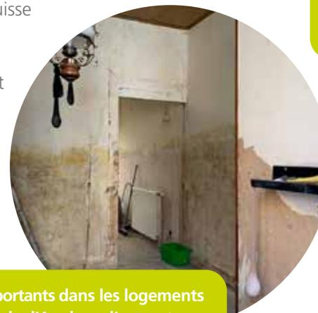
Les dégâts sont très importants dans les logements situés à côté de la centrale d'Angleur : l'eau est montée à plus d'un mètre de hauteur, noyant parfois tout le rez-de-chaussée.
